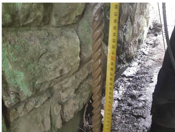
Detekce betonového základu 1,0 m + 0,5 m kamenný polštář.
