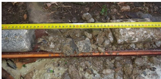
60-60 cm, následuje beton opěry, říční kamenivo netříděné, beton proměnlivé struktury a pevnosti,
